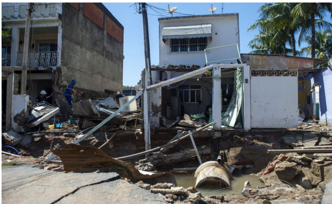
Figura nº 3: Casa destruída após rompimento de adutora da Águas do Rio no bairro Rocha Miranda.
