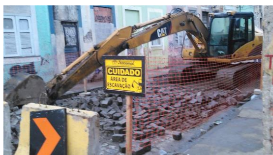
Imagem 04. Obras do VLT Foto: acervo pessoal
