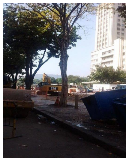
Imagem 05. Obras do VLT Foto: acervo pessoal
