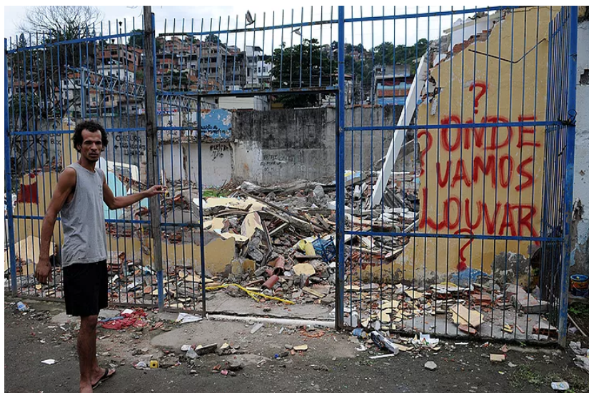
Figura 8 – Demolição da igreja da comunidade. Fonte: Sandro Vox (s/d).
