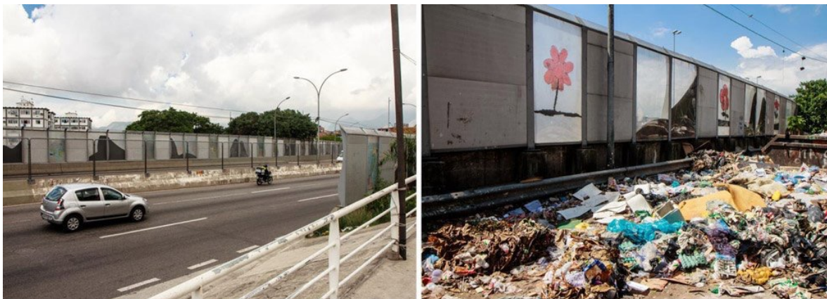
Figura 10 – Barreiras acústicas na Linha Vermelha. Fonte: Cabral (2014).
