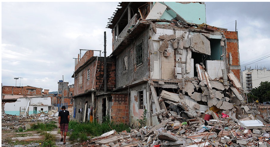
Figura 5 – Demolição na Comunidade Metrô-Mangueira. Fonte: Sandro Vox 23 (s/d).
